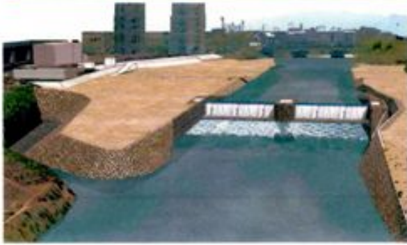
番井井堰付近のイメージ図：井堰が閉鎖し、水量を調整するようになります(7月から上流を流す)
