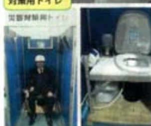
マンホールを利用する災害対策用トイレ
